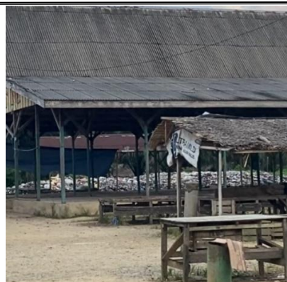
Gambar 1. Kondisi Dusun Sungai Bangkar
