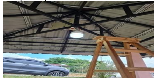
Gambar 3. Menguji fisik kesempurnaan pemasangan solar sel atap ke beban lampu.
