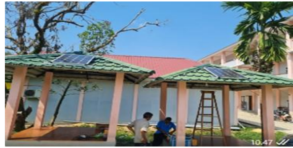
Gambar 2. Pemasangan Lampu Gazbeo berupa lampu LED berbasis solar sel atap.
