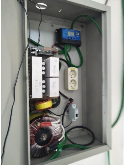
Gambar 5. Rangkaian listrik bagian dalam panel konverter PLTS tahun 2021
