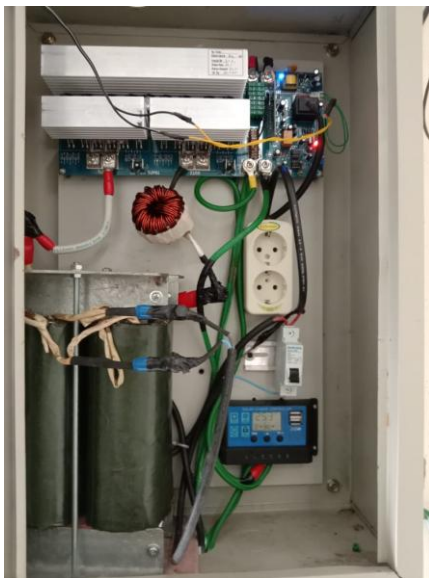
Gambar 6. Rangkaian listrik bagian dalam panel konverter PLTS tahun 2022
