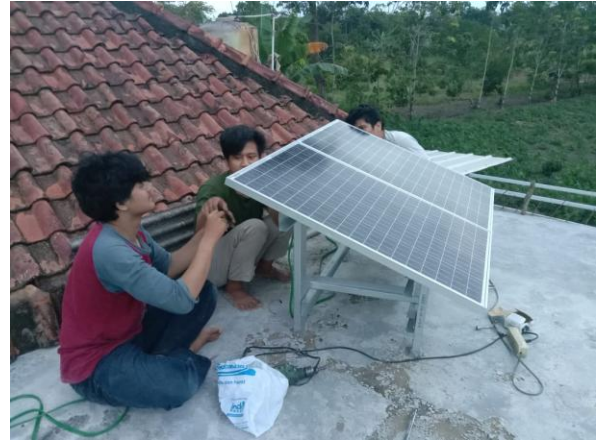
Gambar 7. Mahasiswa sedang melakukan instalasi panel surya di atap Mesjid Aqobah
