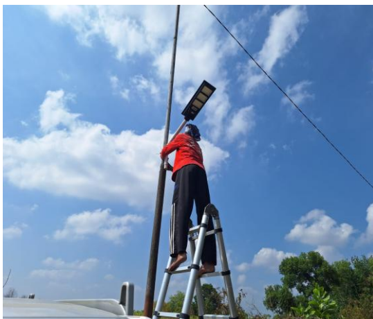
Gambar 4 Tim PPM memasang lampu jalan berbasis PLTS di jalan Ponpes Al Fatah
