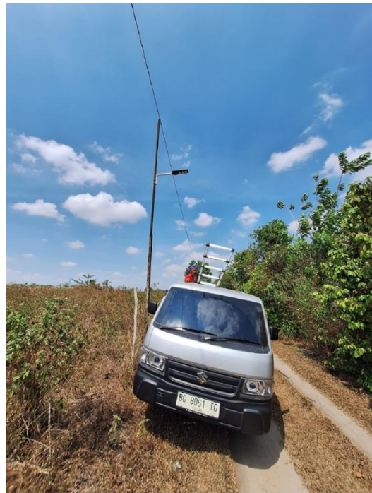
Gambar 5 Lampu PJU dipasang di setiap tiang listrik yang ada di jalan masuk Ponpes
