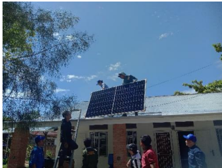
Gambar 3. Pemasangan Papan Panel Kekurangan PLTS Off Grid
