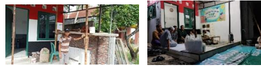
Gambar 5. Kondisi Pos Kamling RT 02 RW 04 Mangunsari, Gunungpati Saat Renovasi dan Sesudahnya
