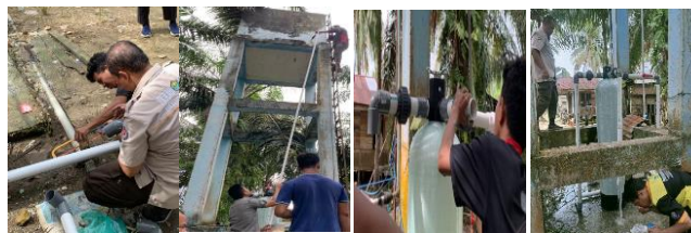
Gambar 4. Kegiatan pemasangan/instalasi alat penjernih air di tempat fasilitas umum Desa Buluh Cina
