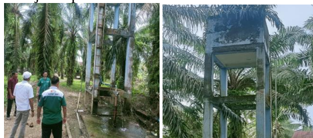
Gambar 2. Hasil survey lapangan posisi pemasangan/instalasi penjernih air
