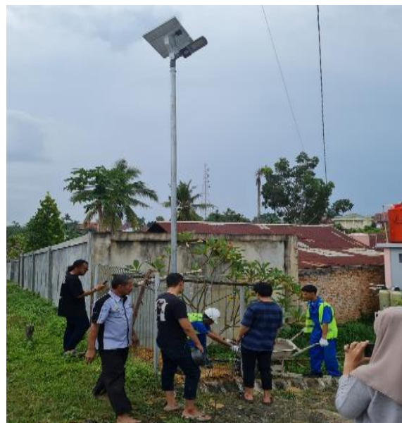
Gambar 4. Finishing Tiang Penyangga Solar Panel dan Lampu LED
