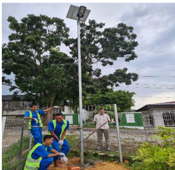
Gambar 3. Finishing Tiang Penyangga Solar Panel dan Lampu LED 1
