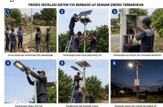
Gambar 2. Proses Instalasi Sistem PJU
