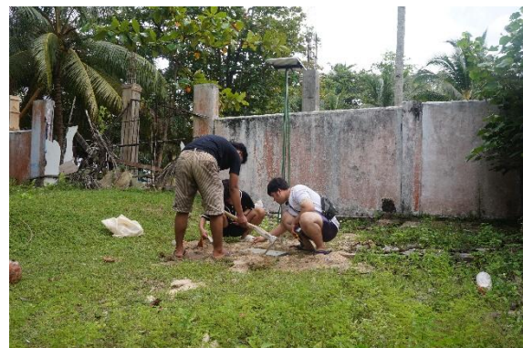
Gambar 5 Proses instalasi detektor kedua di Pantai Walur yang tidak terkena air pantai
