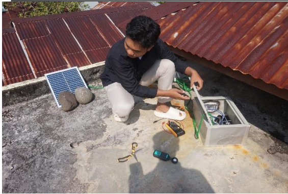
Gambar 6 Proses instalasi detektor ketiga di atap rumah warga di pemukiman
