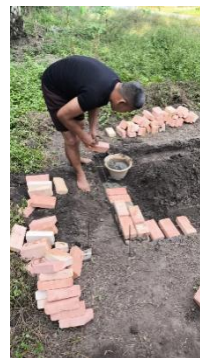
Gambar 1. Proses peletakan batu pertama pembangunan rocket stove
