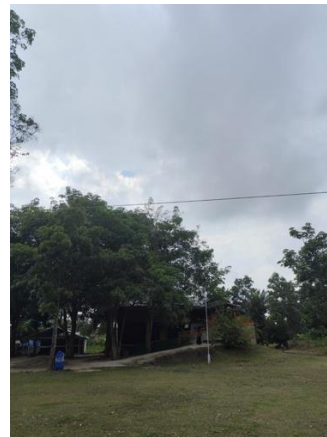
Gambar 9. Pemasangan Slink Flying Fox
