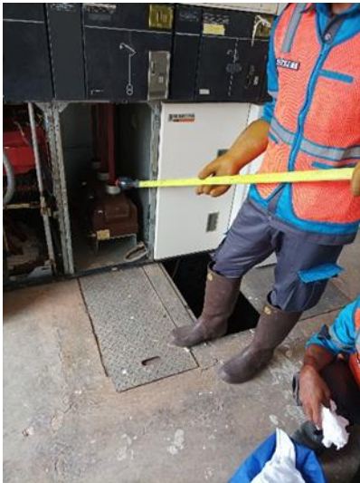
Gambar 5. Pengecekan Tegangan Menggunakan Volt Detector
