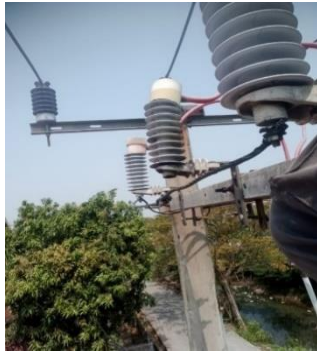
Gambar 4. Sebelum Penggantian Arrester
