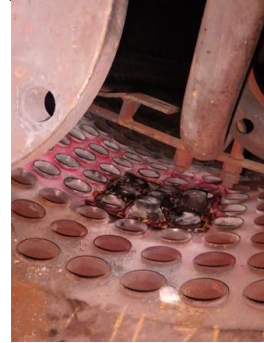
Gambar 9. Plugging pada Pipa Boiler
