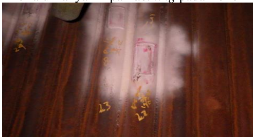
Gambar 8. Patching pada pipa boiler
