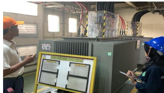
Gambar 4. Transformator 2000 kVA
