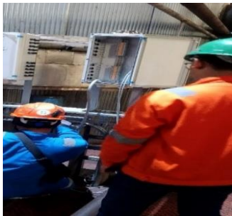
Gambar 6. Pemasangan Kabel ke Junction Box
