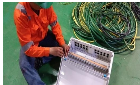
Gambar 5. Pembuatan Junction Box
