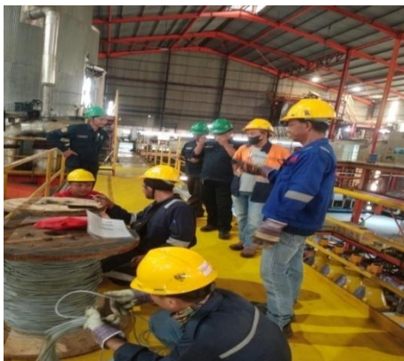
Gambar 7. Pemasangan Kabel Selenoid ke Panel DCS
