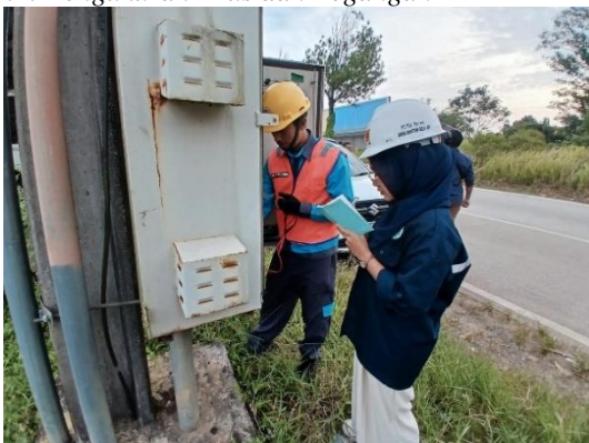
Gambar 3. 1 Pengecekan Gardu Distribusi PLTT230
