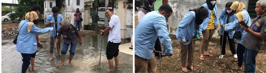
Gambar 5. Pembuatan Lubang Biopori Untuk Meningkatkan Sanitasi Sebagai Bentuk Penanggulangan Stunting Berbasis Lingkungan
